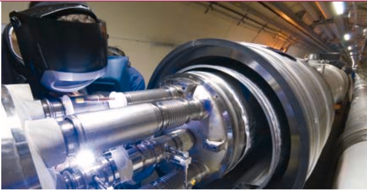
Montagem do LEP
