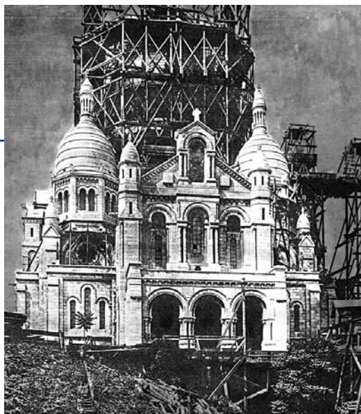
La basilique du Sacré-Cœur en construction – une pierre blanche qui ne connaîtra jamais de patine
